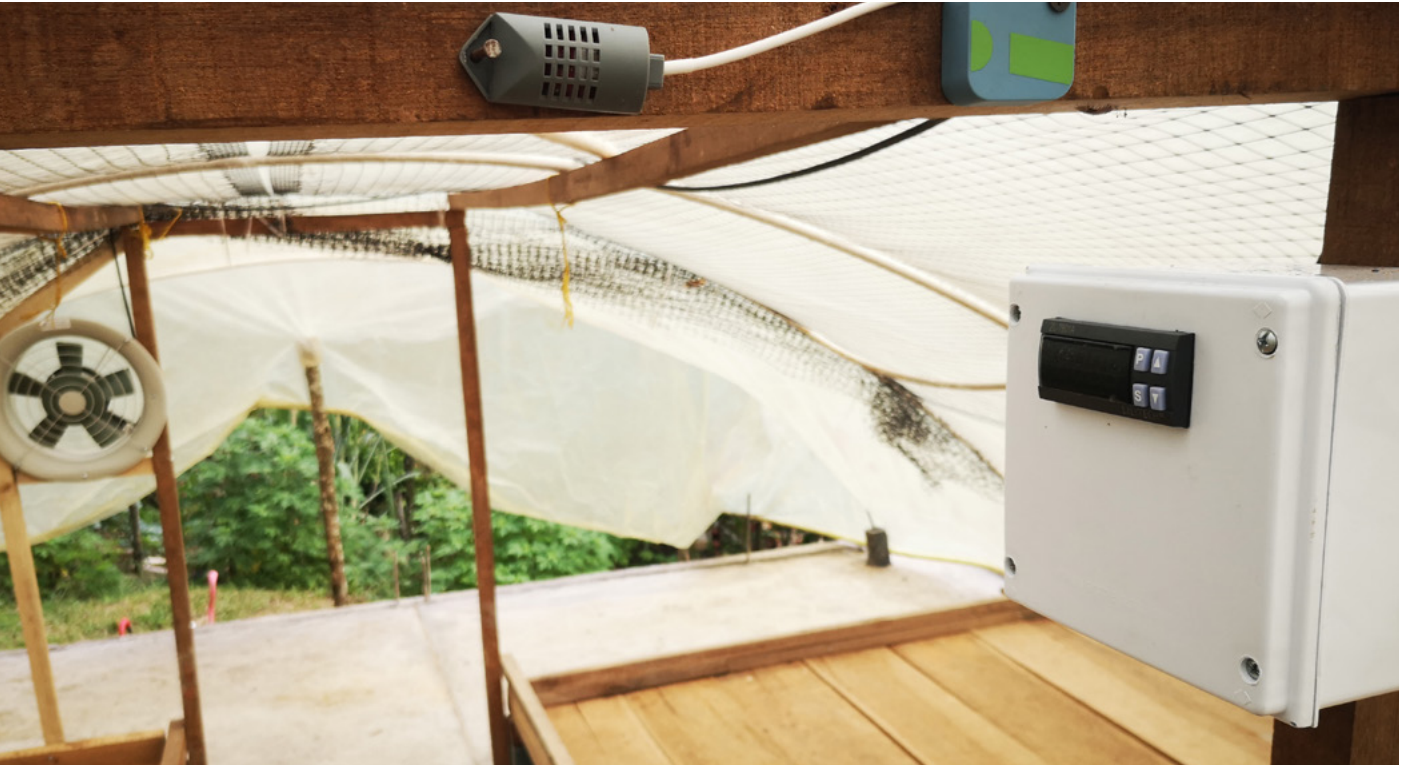
↓ Figura 22. Sistema automatizado de regulación de humedad y temperatura en cacao
