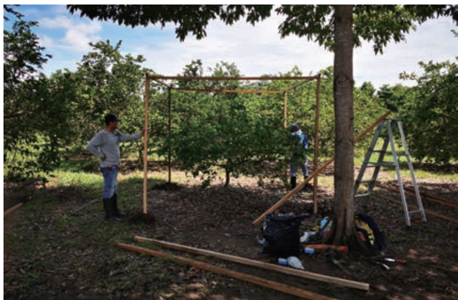
Figura 29. | Colocación de los parales laterales.
