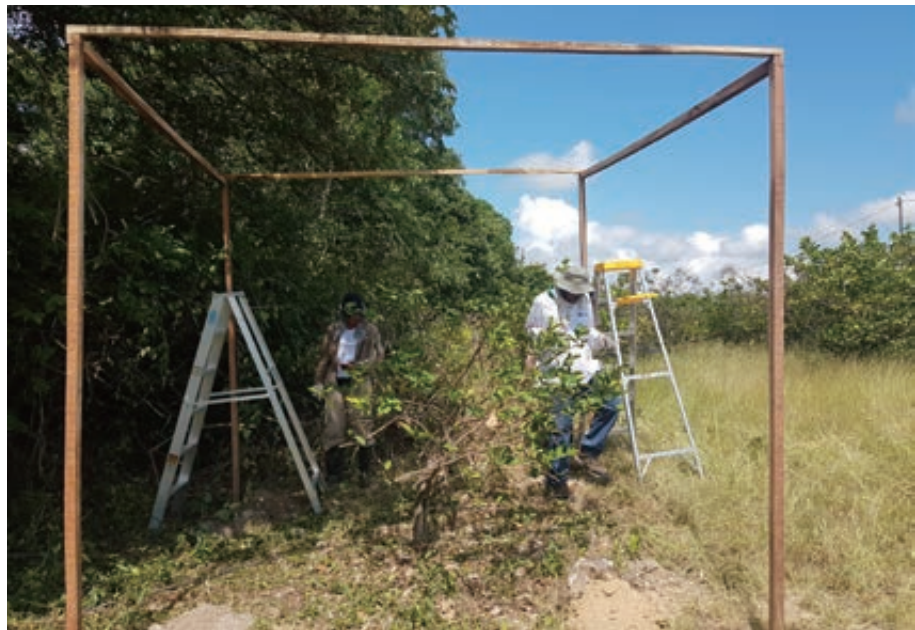
Figura 30. | Colocación de los soportes del techo.
