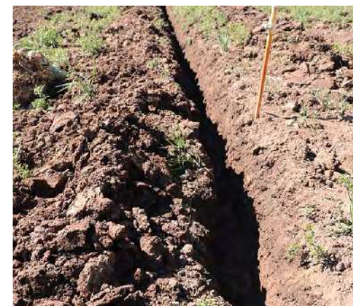
Figura 23. Sistema de drenaje para manejar los problemas de saturación hídrica. Foto: Ivonne Tristancho.
