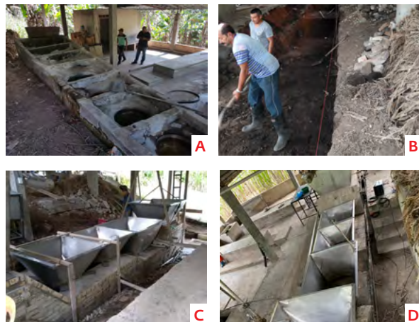
Figura 1. Implementación de hornilla híbrida en la vereda San Isidro (Ricaurte), Asociación Famiempresas de San Isidro. a. Estado inicial; b. Nivelación; c. Instalación de pailas; d. Estado final.
