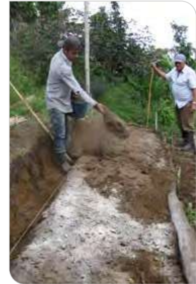
Figura 4. Aplicación de correctivos. Foto: Jorge Bernal
