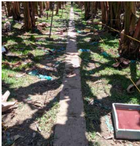
Figura 10. Vista de placa-huella en condiciones de campo.
