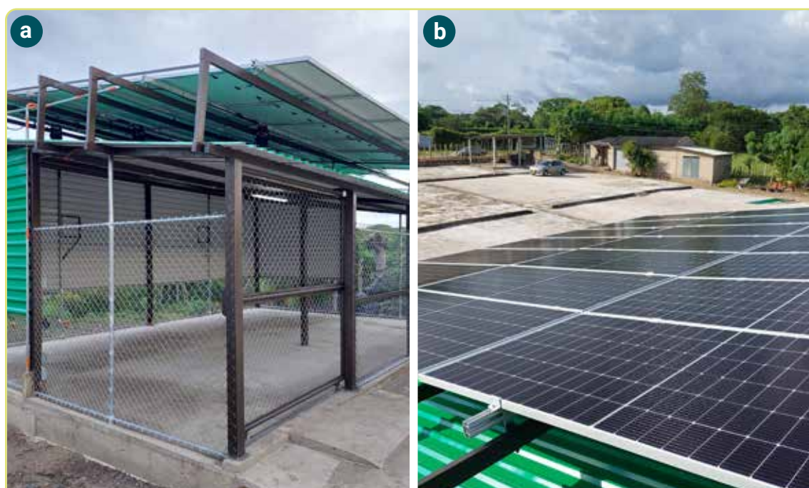
Figura 5.4. Infraestructura de un sistema fotovoltaico como fuente de energía en el secado de yuca. a. Infraestructura bifuncional para protección y soporte de paneles solares; b. Paneles solares.
