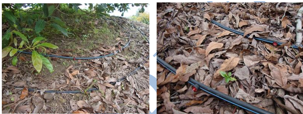
b. Técnica de distribución de agua: Doble anillo de manguera por árbol.
