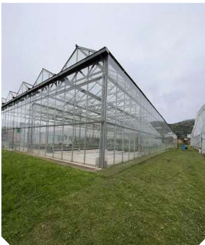
Figura 20. Invernadero tipo venlo con cubierta de vidrio.
