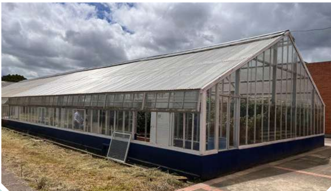
Figura 27. Invernadero con cubierta en policarbonato y costados laterales y fachadas en vidrio.
