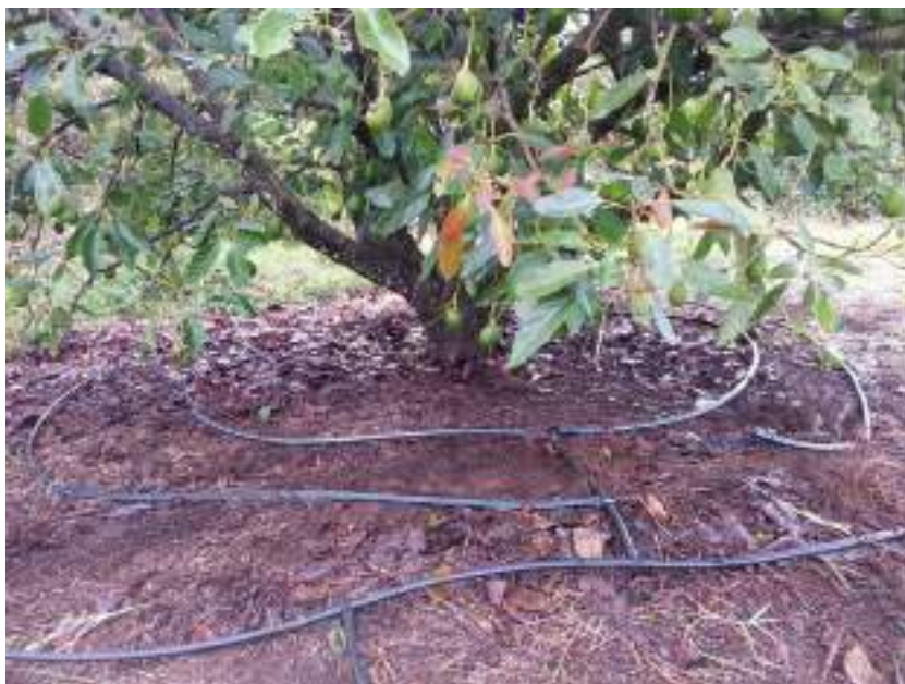
Figura 41. Sistema de riego instalado en campo.
