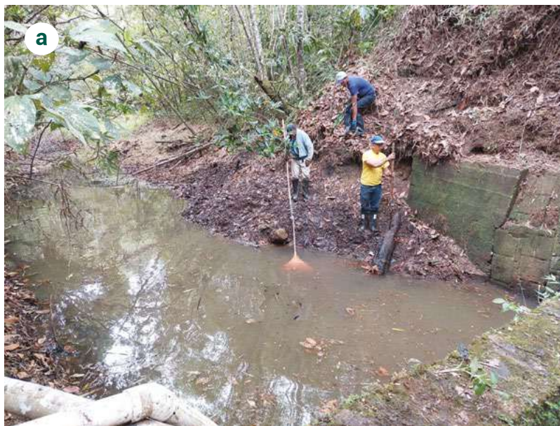
Figura 50. Mantenimiento del sistema de riego por goteo en parcela experimental de aguacate Hass en el departamento del Cauca. a. Limpieza de fuente de agua; b. reparación de fugas en tuberías de conducción de agua; c. revisión del funcionamiento de emisores de riego (goteros o microaspersores).
