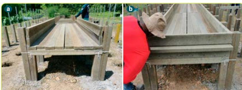
Figura 4.9. Instalación de las tablas para sostener el sustrato. a. Instalación de madera para la superficie y los laterales de la cama central; b. Instalación de tabla lateral frontal para el cerramiento de la cama central.
