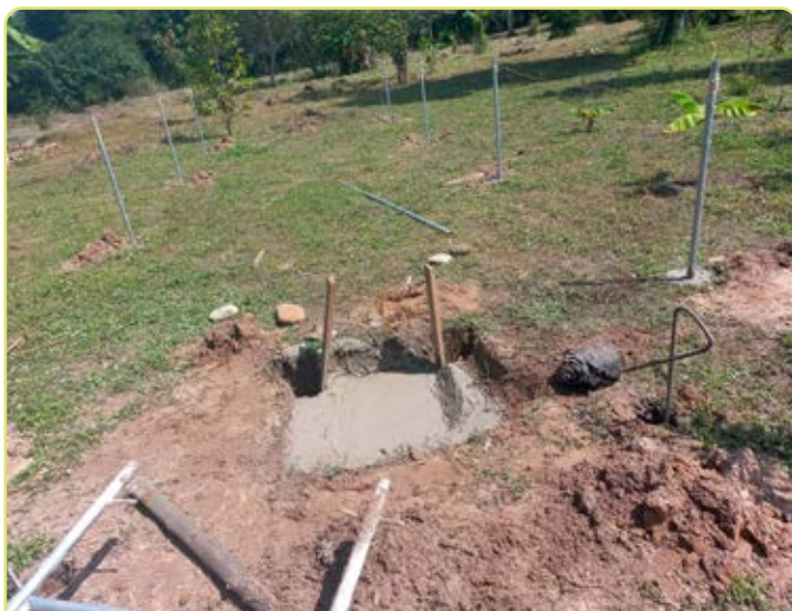
Figura 4.19. Bases, tensores y área de desinfección fundidos.
