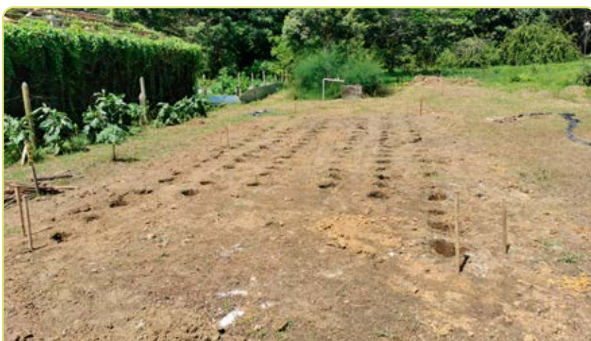
Figura 4.3. Ahoyado para la instalación de zapatas para cama central, mesas laterales y la estructura del túnel.
