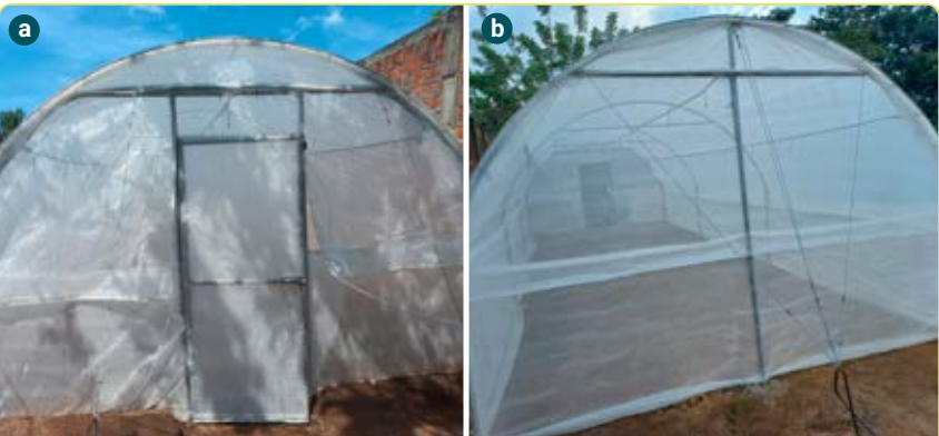
Figura 3.2. Túnel de multiplicación en tubo galvanizado. a. Vista frontal; b. Vista posterior.
