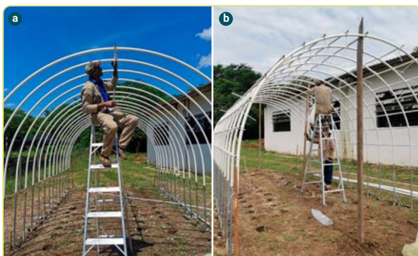
Figura 4.10. Instalación de la estructura del túnel de multiplicación con tubos pvc. a. Arcos con tubos PVC de 1" anclados a los tubos galvanizados de cada zapata; b. Estructura con tubería PVC \frac{4}{3} " laterales, para amarrar los arcos. Esto da firmeza a toda la estructura.
