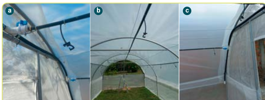
Figura 4.24. Instalación de tres líneas de microaspersión y del tapón de lavado. a. Detalle de las tres líneas; b. Distribución general; c. Tapón de lavado.
