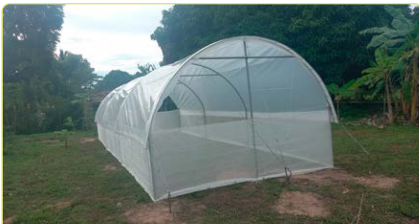
Figura 4.22. Instalación del plástico.
