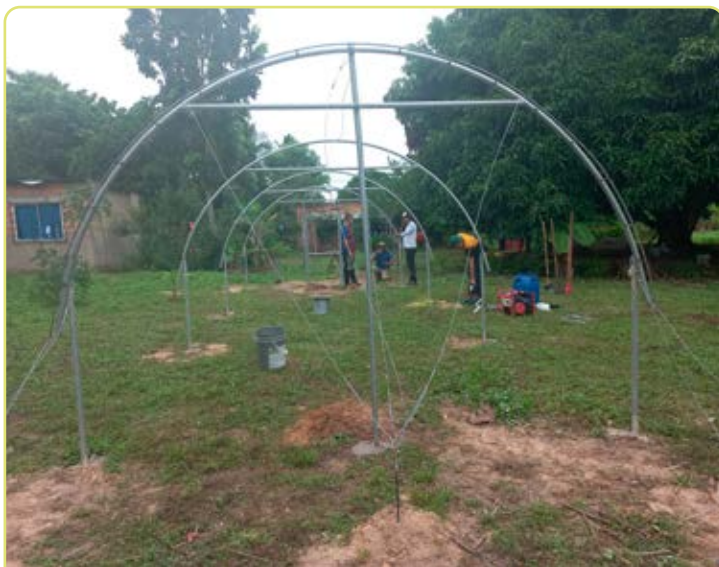
Figura 4.20. Instalación de arcos y tendido de guayas.
