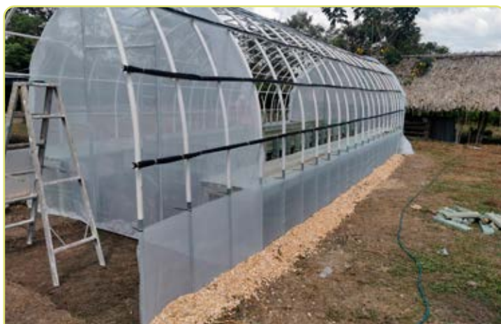
Figura 4.11. Instalación del plástico y la malla antiáfidos.
