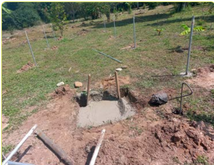
Figura 4.19. Bases, tensores y área de desinfección fundidos.
