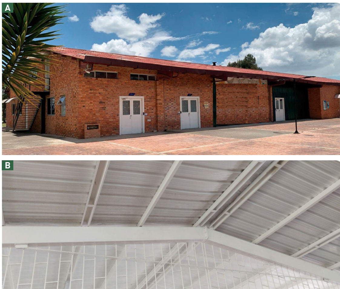
Figura 8. Techo con inclinación para reducir acumulación de suciedad. a. Externo; b. Interno.
