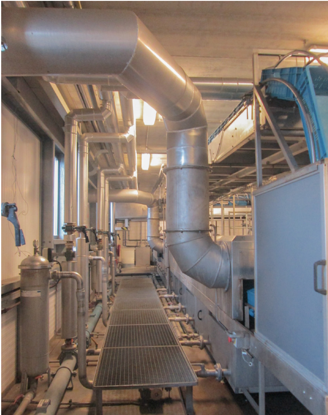
Figura 7. Espacio entre paredes y equipos para facilitar la inspección y limpieza.
