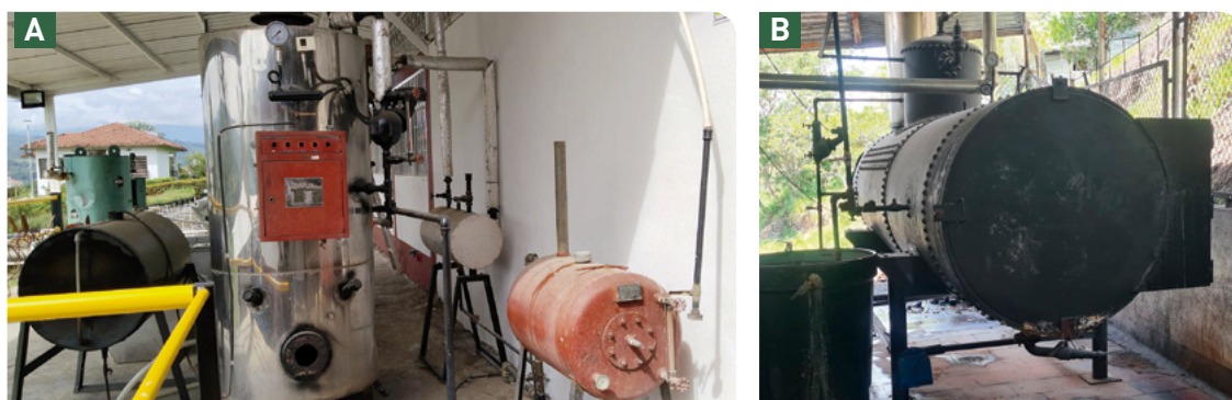
Figura 23. Calderas pirotubulares. a. Vertical; b. Horizontal.
