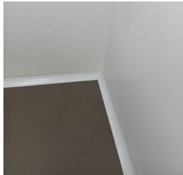
Figura 9. Uniones redondeadas de piso a pared.
