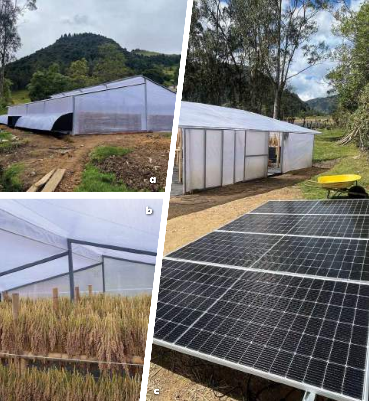
Figura 8.11. Secador de quinua construido. a. Vista frontal; b. Cámara de secado; c. Sistema fotovoltaico para suplir requerimientos eléctricos del proceso.
