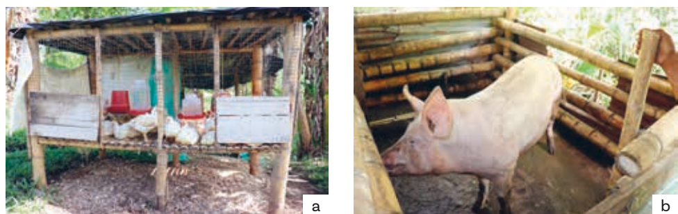
Figura 32. La guadua es el material autóctono más utilizado en la construcción de instalaciones para especies menores en las 32 comunidades del resguardo Cañamomo Lomapieta. a. Corral tradicional con guadua y madera reciclada para pollos de engorde, comunidad Santa Ana, Supía; b. Corral de porcinos hecho con guadua, en la comunidad de Santa Ana, Supía, Caldas.
