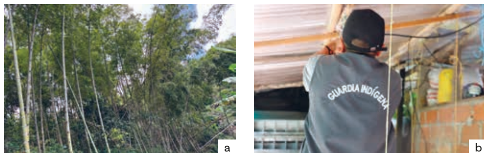
Figura 33. La guadua es el material base utilizado para la construcción de instalaciones para la cría de especies menores en el resguardo Cañamomo Lomaprieta. a. La “curación” de la guadua se hace a partir de conocimientos ancestrales para que el material esté libre de plagas y tenga mayor durabilidad; b. Construcción de galpón comunitario para gallinas ponedoras con guadua, en la comunidad de Panesso, Riosucio, Caldas.
