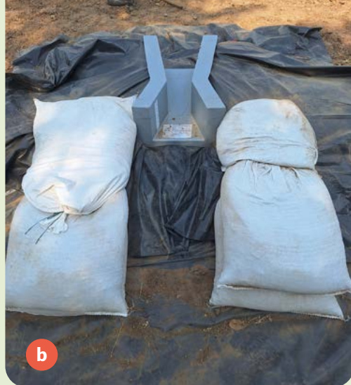
Figura 21. Diseño y construcción bocatoma principal para entrada de agua de riego a canaleta aforadora y manguera de riego MIRI. a. Estructura conectada a la canaleta aforadora para control del ingreso de agua; b. Proceso de construcción y sellado de la bocatoma con sacos y geomembrana previo a su conexión con la manguera.
