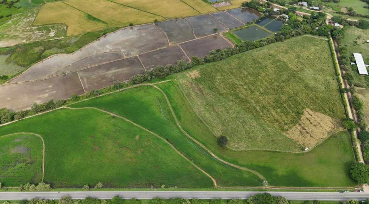
Figura 15. Diseño y construcción de piscinas de siembra siguiendo curvas de nivel.
