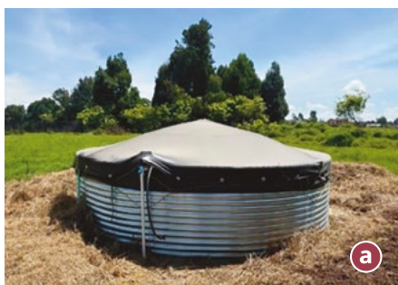
Figura 8. Componentes de un sistema de riego. a. Fuente de agua en tanque australiano; b. Sistema de filtrado; c. Equipos de bombeo; d. Válvulas de campo y manómetro.
