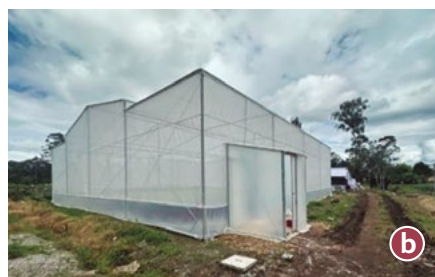
Figura 7. Diferentes tipos de cubierta en viveros. a. Cubierta en malla sombra; b. Cubierta en malla antiinsecto; c. Cubierta en rafia plastificada; d. Cubierta mixta plástico y malla sombra de color.
