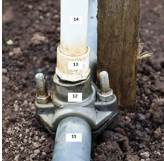
Figura 8.11. Instalación del aspersor.
