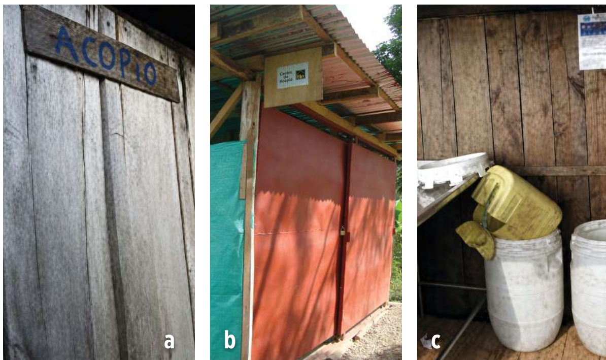
Figura 11.8. Ejemplos de áreas de acopio construidas en diferentes materiales. a. Sitio de acopio construido en madera; b. Sitio de acopio construido en madera, plástico y zinc; c. Mesa de acero inoxidable para acopio.
