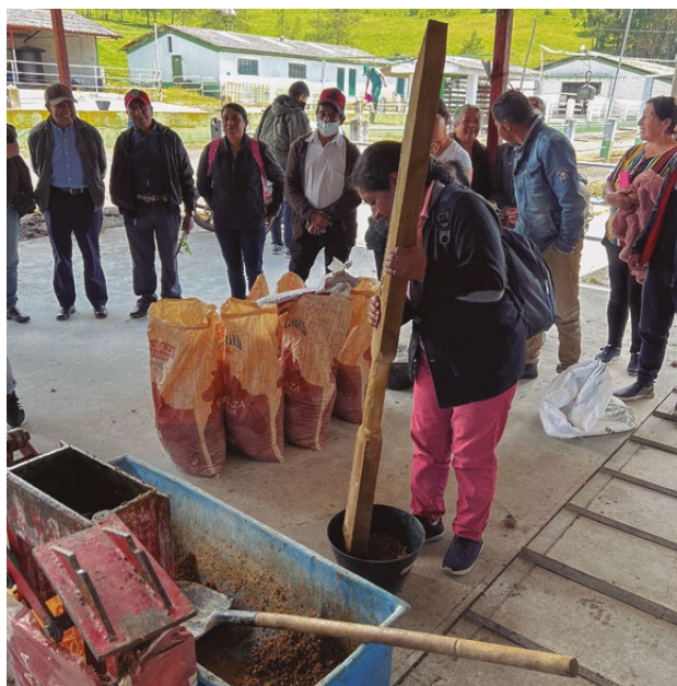
Figura 31. Compactación de BMN en balde de construcción.
